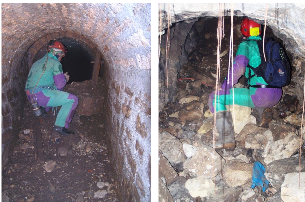
Fig. 3.1 - I depositi di materiali di risulta scaricati abusivamente dalla superficie attraverso i pozzetti di ispezione. A sinistra, un cumulo superabile, a destra il cumulo impedisce la progressione sotto il pozzo n.5.
