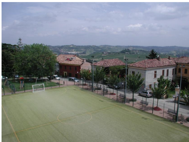
Fig. 3 - L'area sommitale di Agliano Terme, sede della maggior parte degli sprofondamenti.
