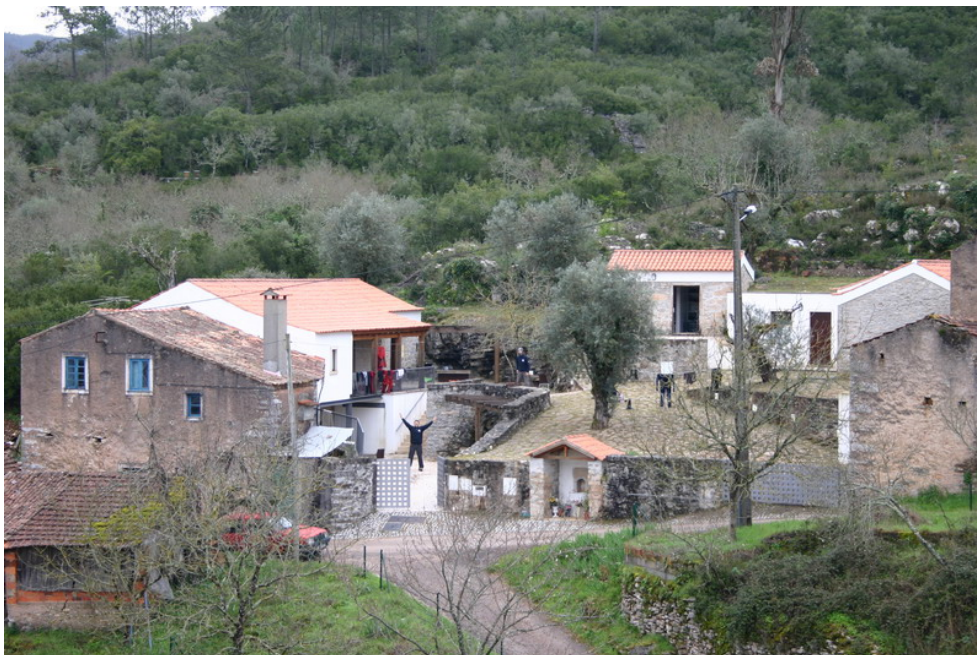
Fig. 16 - Panorama sul CISED (gli edifici restaurati) nel comune di Penela, frazione Ferrarias.
