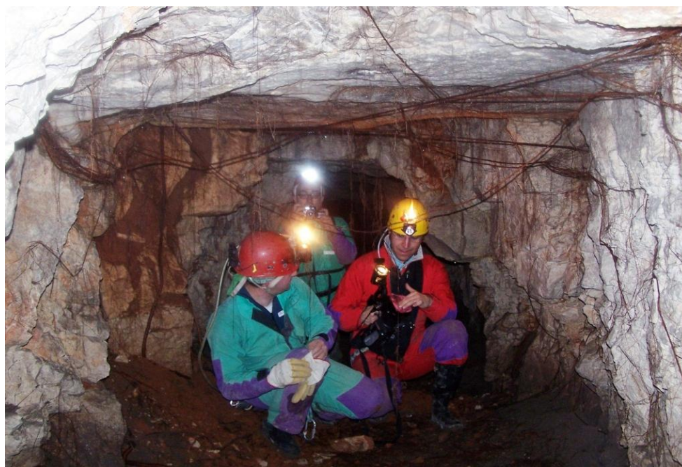
Fig. 3.3 - Un aspetto della galleria nei tratti non rivestiti. Sezione quadrata, per via della stabilità dello strato calcareo al tetto, presenza di radici e infiltrazioni di terra rossa (a sinistra) attraverso cavità carsiche intercettate dallo scavo.
