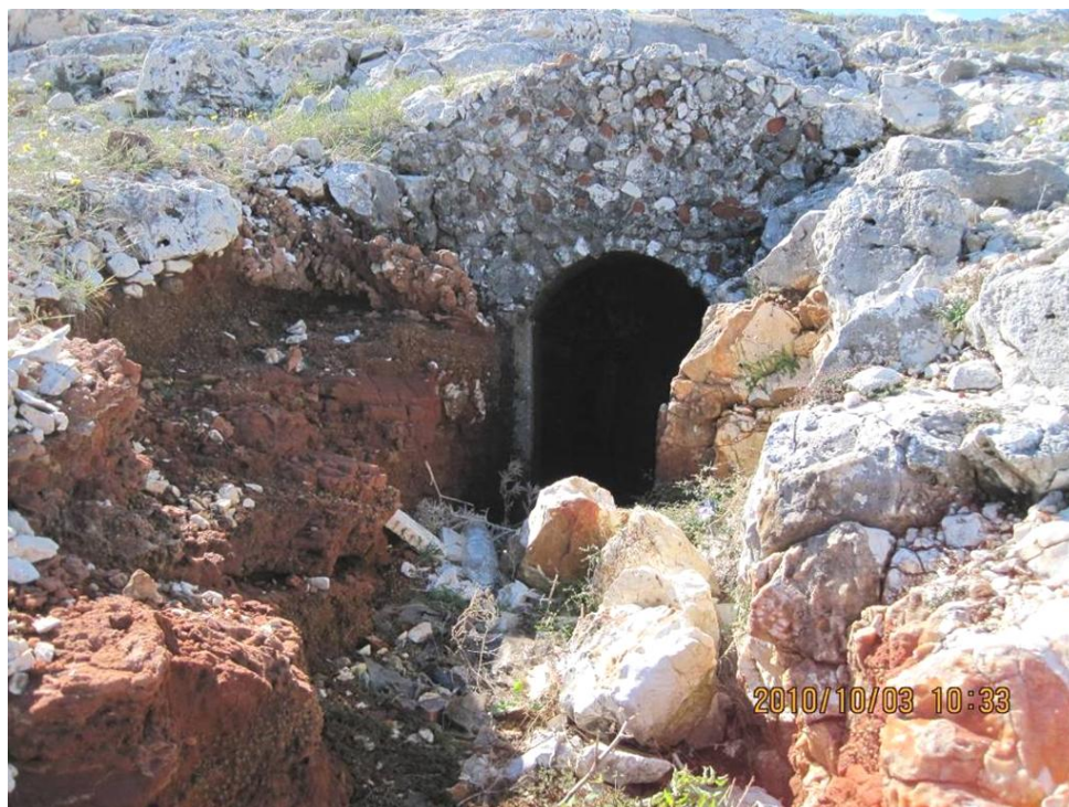
7) Ingresso Bunker nord - Otranto loc. Orte
