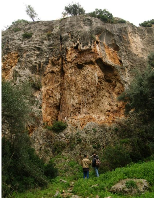
Fig. 2 - Esempio di frattura verticale (foto Gentile G.C.)
